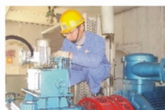
罗宏霖，机械工程学院机电一体化技术专业毕业生，任阳泉华观燃气有限公司副站长，年薪10万元以上。
