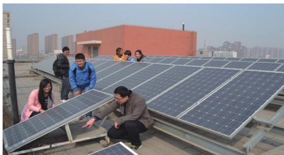
光伏并网发电实验室
