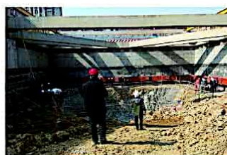
边坡支护及深基坑工程
