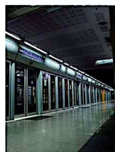
城市地下空间开发与地铁站工程
