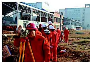
工程测量实习训
