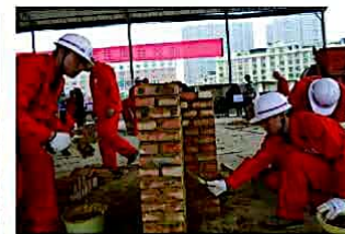
砌筑工程施工实训
